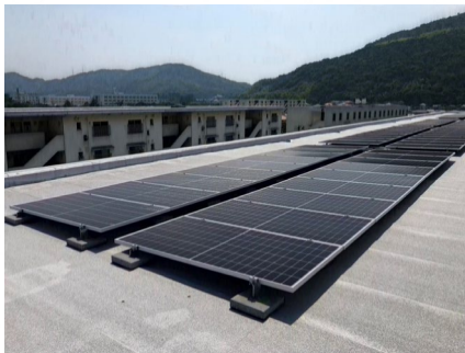
旧雇用促進住宅屋根上
