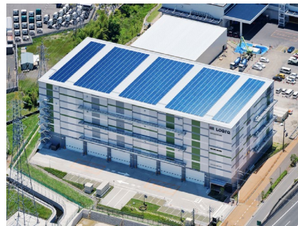
リエネ LOGI'Q 枚方太陽光発電所
