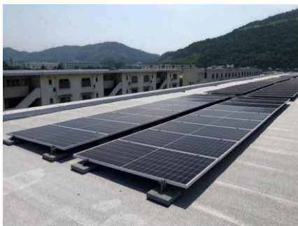
旧雇用促進住宅屋根上
